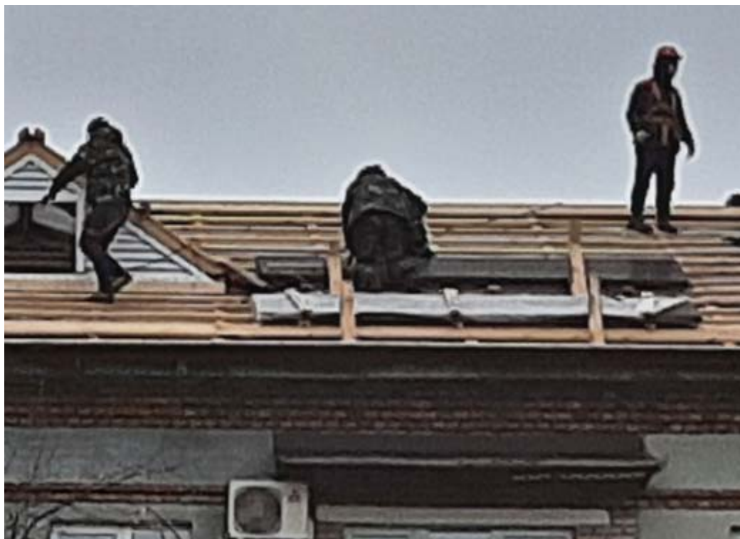
Работники производят работы по устройству кровли без использования СИЗ и средств защиты от падения с высоты (поясов предохранительных и страховочных канатов)
