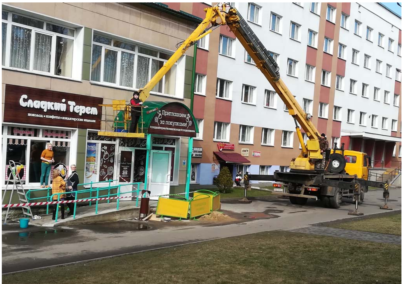
Работник выполняет работы по мытью козырька в люльке подъёмника без пояса предохранительного и каски защитной
