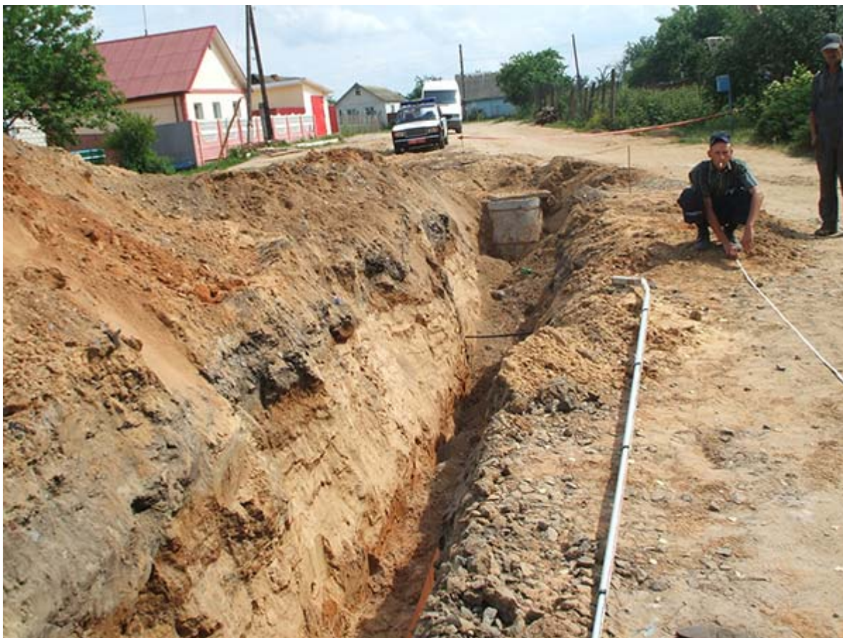
Отвалы грунта расположены по краю выемки. Не установлены ограждения опасных зон. Не оборудованы места для спуска рабочих в траншею и выхода из неё
