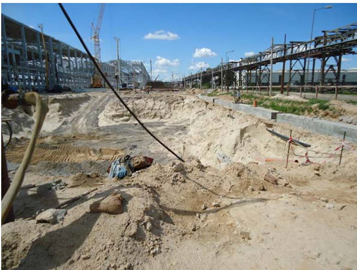
Котлован не ограждён. Откосы образуют вертикальные стенки и козырьки
