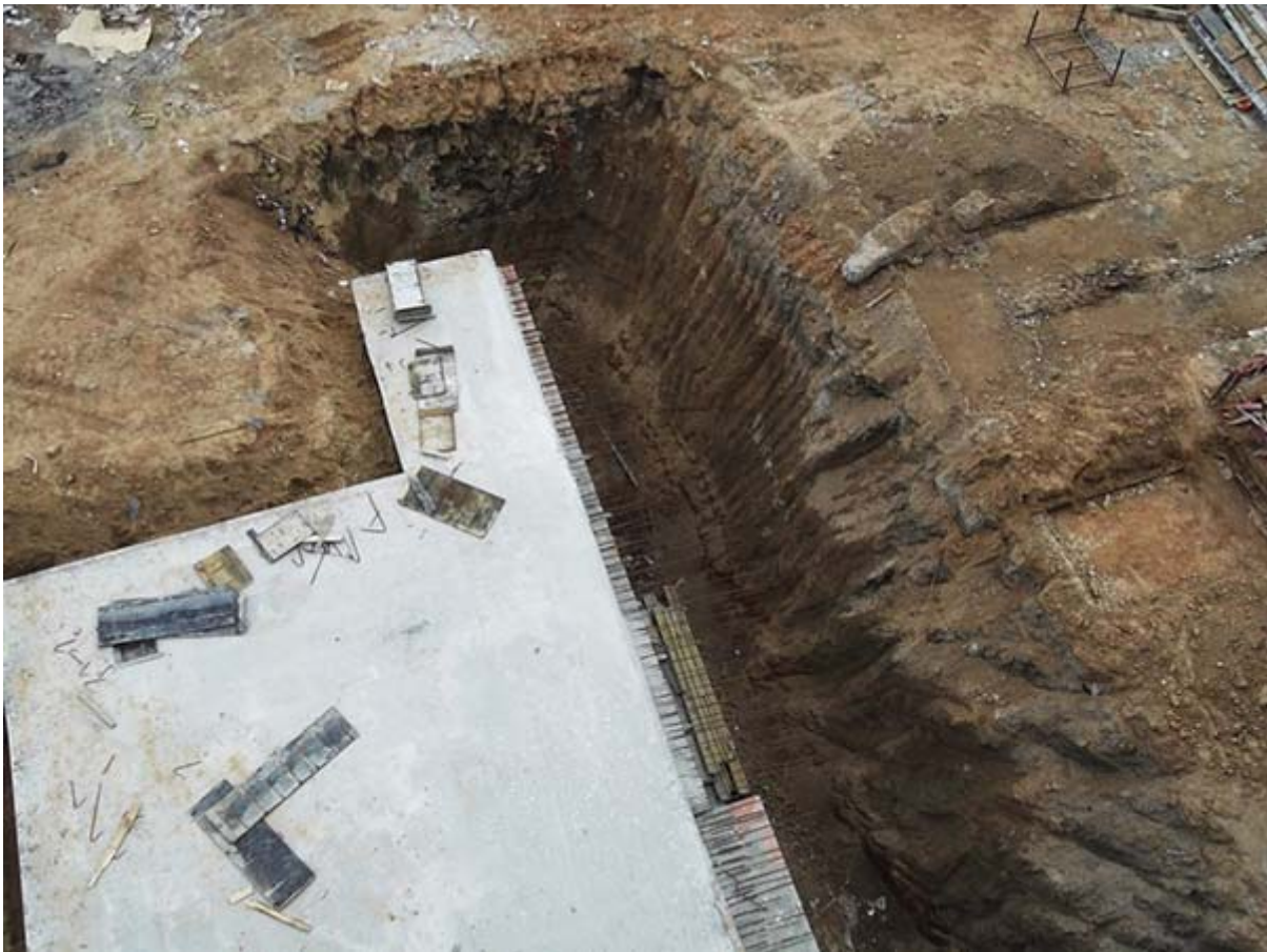
Котлован на объекте строительства, где происходит движение людей и транспорта, не ограждён защитным ограждением
