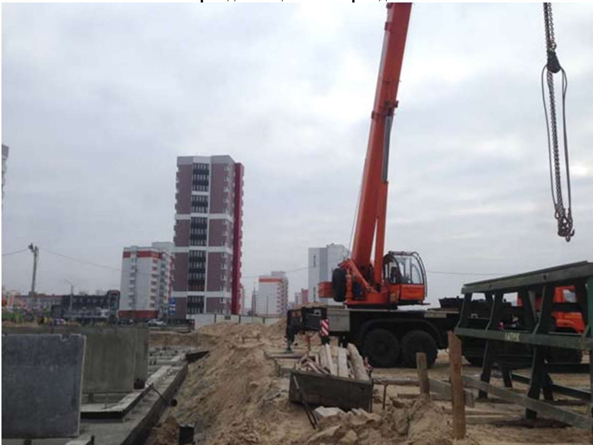
Работа автомобильного крана осуществляется вблизи котлована с неукреплёнными откосами на расстоянии (по горизонтали от основания откоса выемки до ближайшей опоры строительной машины) менее 1,0 м при песчаном (супесчаном) грунте
