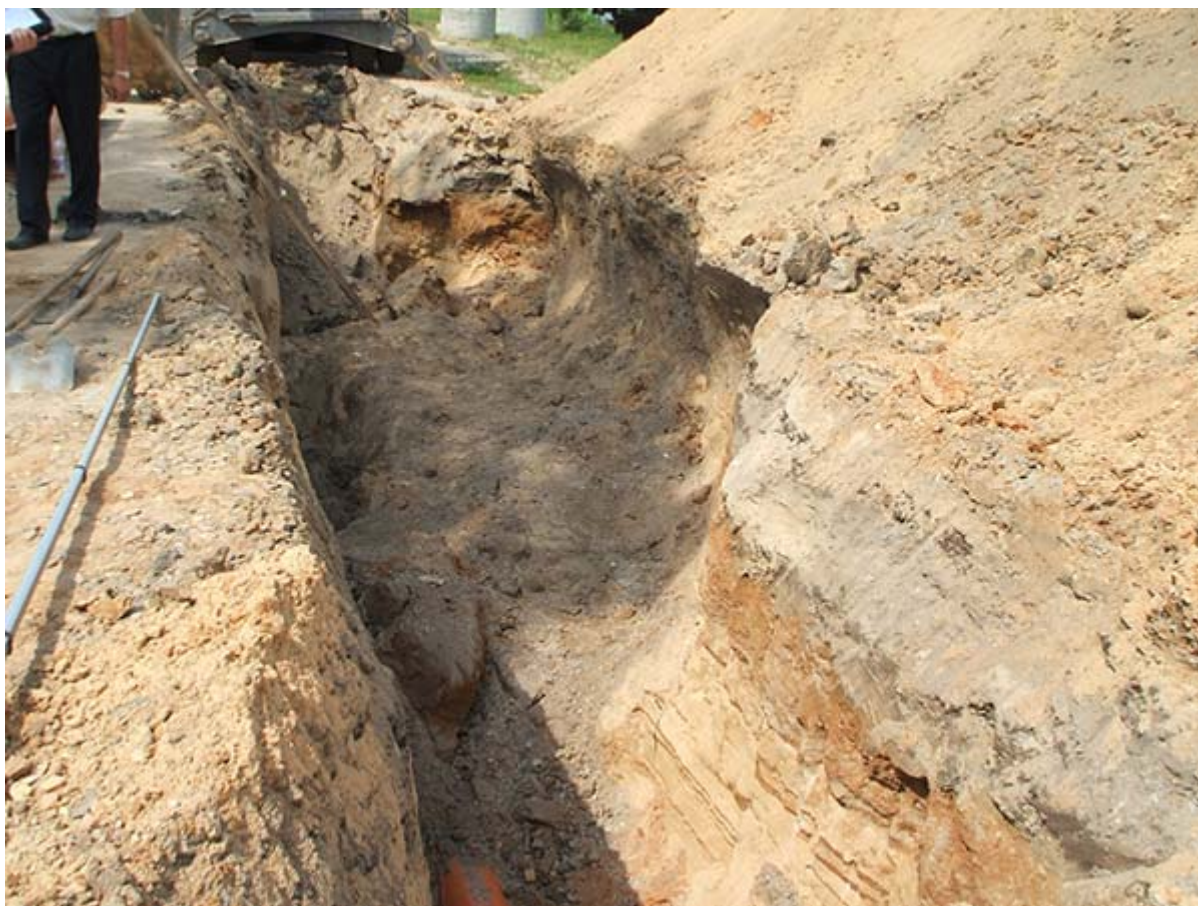
Стенка траншеи имеет малый размер откоса, выполненный без учёта неоднородной структуры грунта. Происходит обрушение грунта
