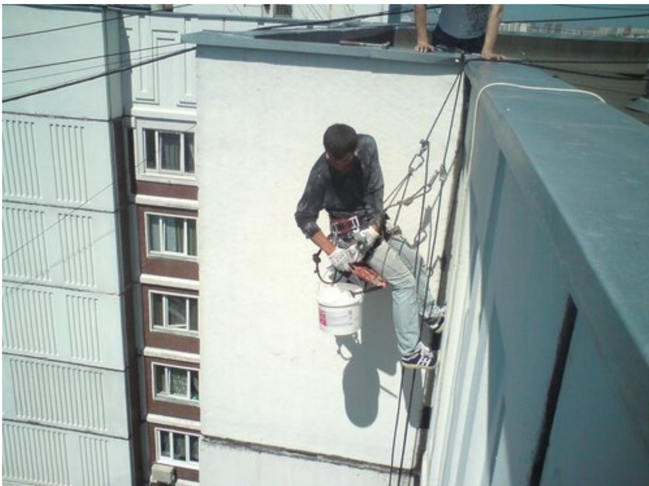
**Отсутствует защитная каска у работающего,
