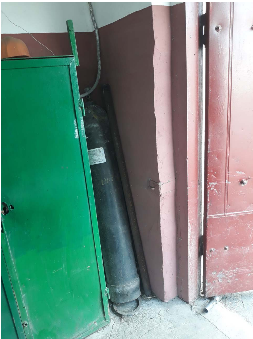
Нарушение порядка хранения баллонов с газом
