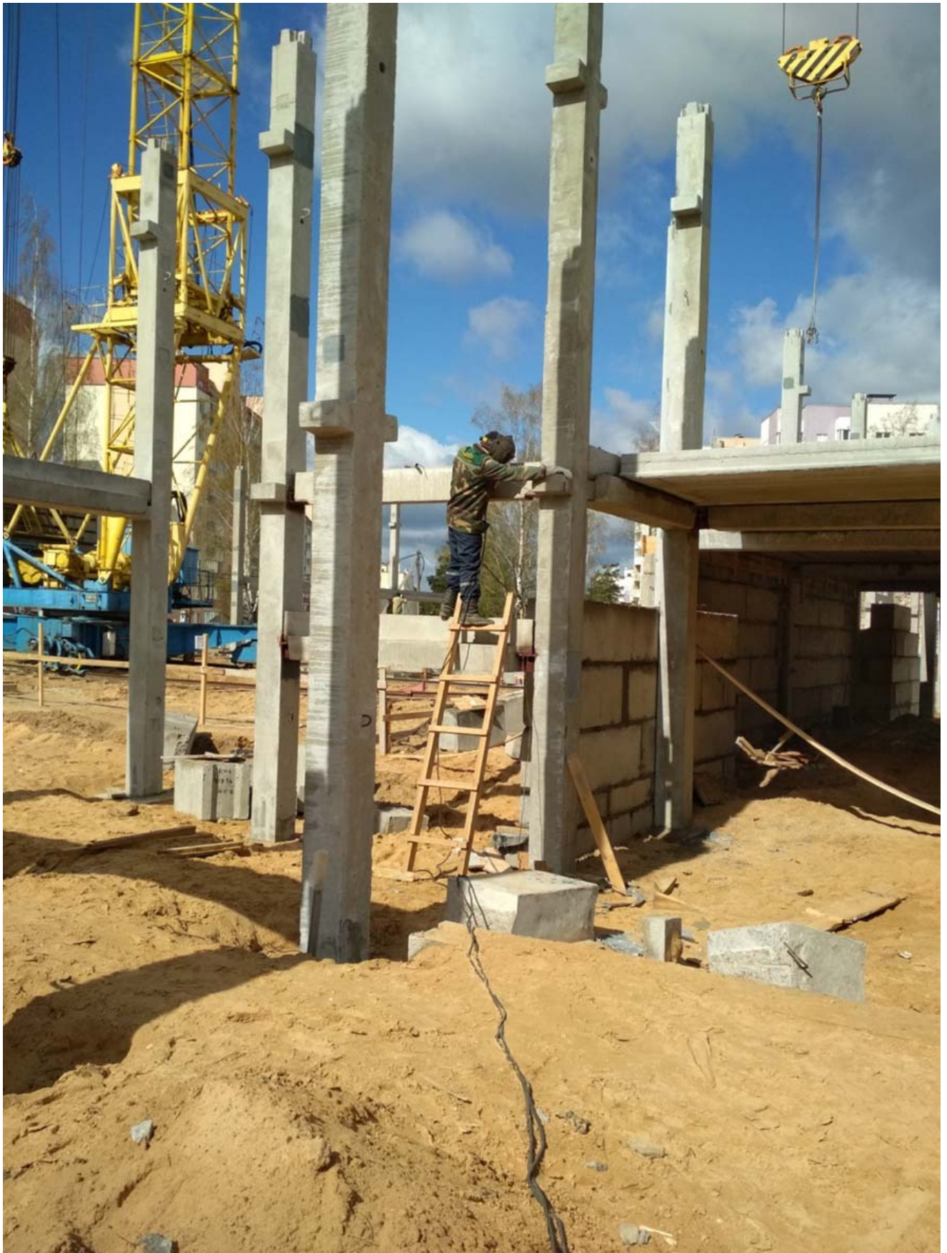
Выполнение электросварщиком сварочных работ на высоте выше 1,3 м с приставной лестницы без применения предохранительного пояса
