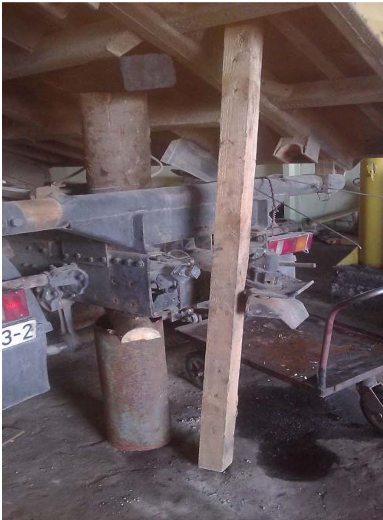
при ремонте автомобиля МАЗ вместо специальных упоров под поднятый кузов применяются случайные предметы (деревянный брусок и деревянная колодка)
