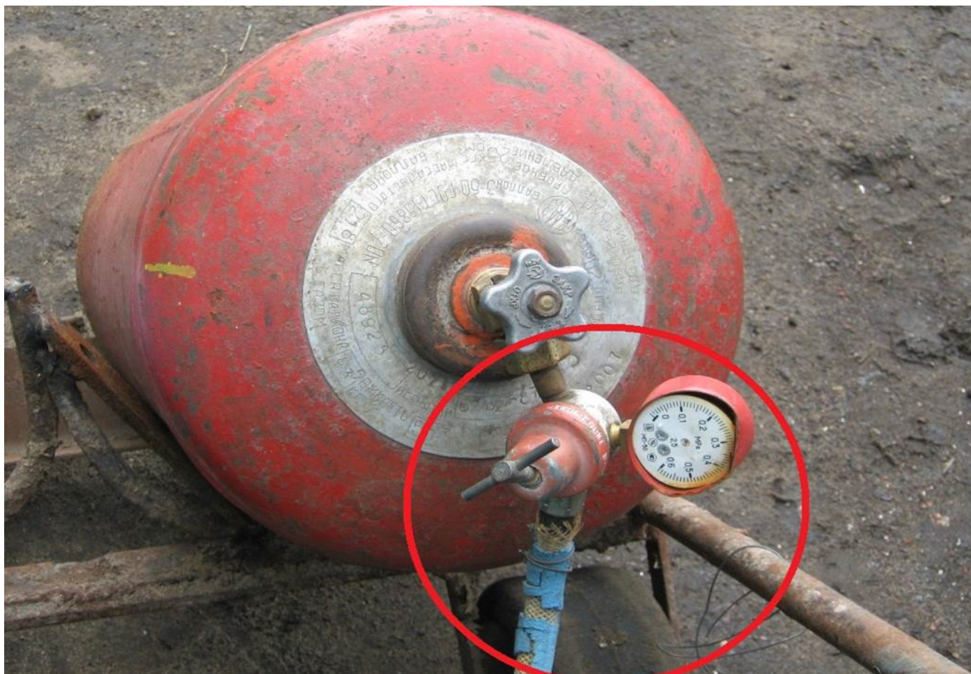
Газовый редуктор и манометр повреждены. Шланг с повреждённой наружной оболочкой зажат скруткой проволоки
