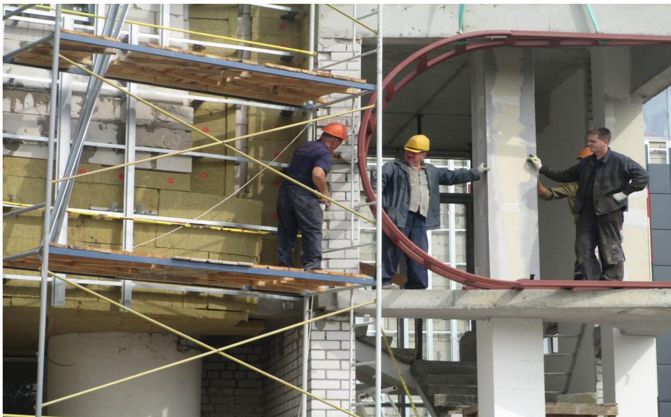
*Работники находятся на расстоянии ближе 2 метров от неограждённого перепада по высоте более 1,3 метра без страховочных канатов и предохранительных поясов, один из них без защитной каски*
