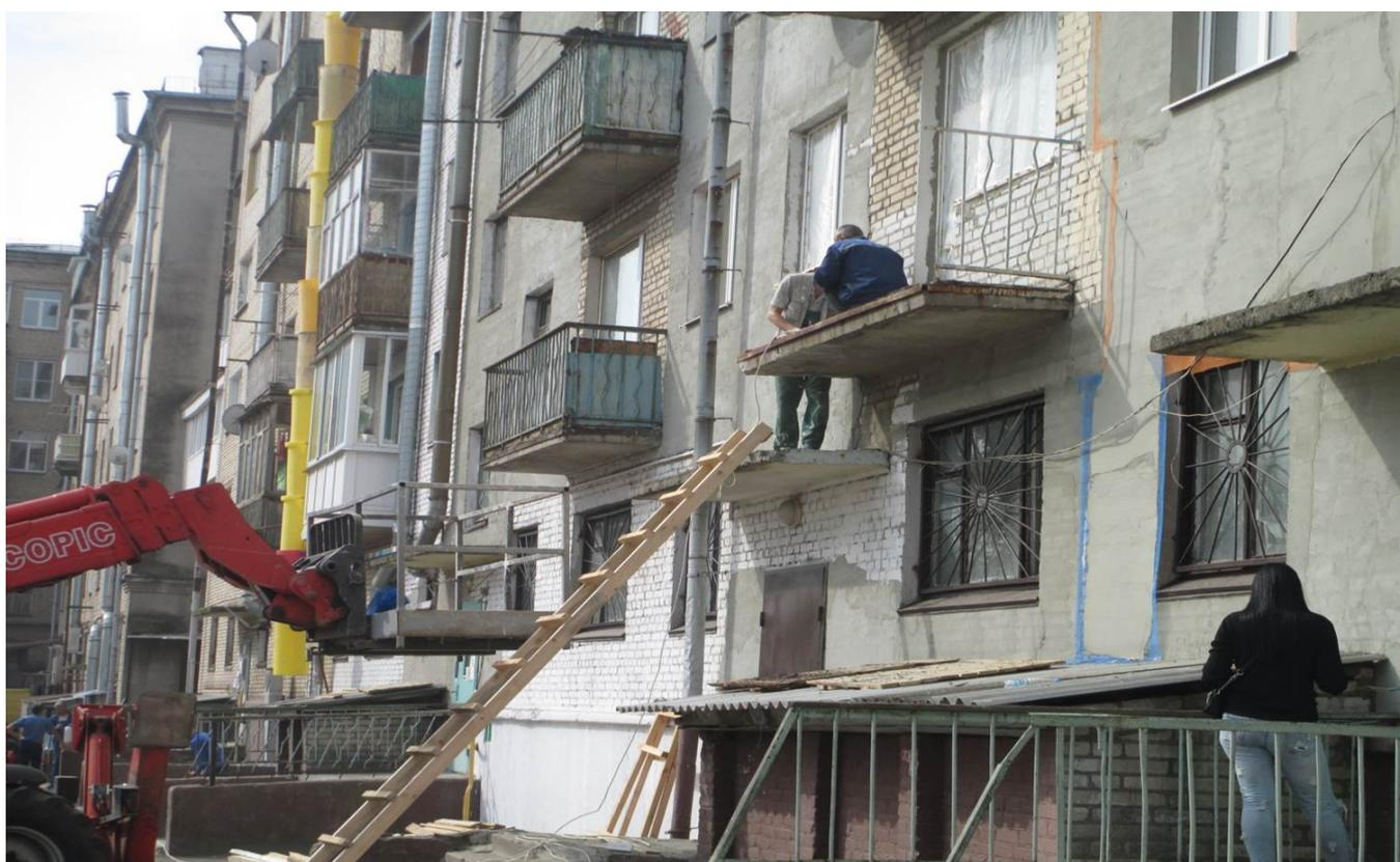
*Лестница, применяемая для выполнения работ на высоте, не отвечает требованиям законодательства об охране труда, работники находятся на расстоянии ближе 2 метров от неограждённого перепада по высоте более 1,3 метра без страховочных канатов и предохранительных поясов, без защитных касок*
