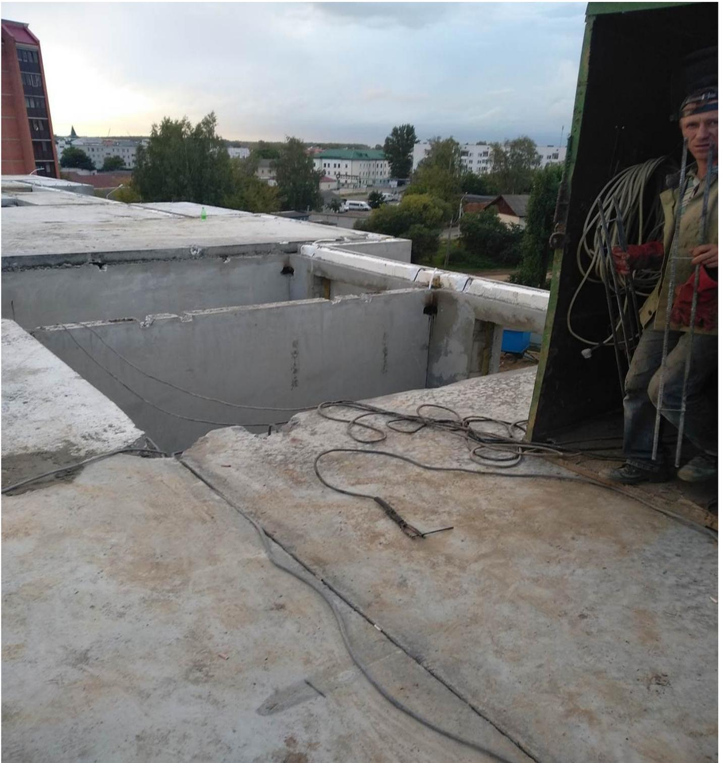
*На 3 этаже строящегося здания не ограждены перепады по высоте, работники выполняют работы без страховочных канатов и предохранительных поясов*
