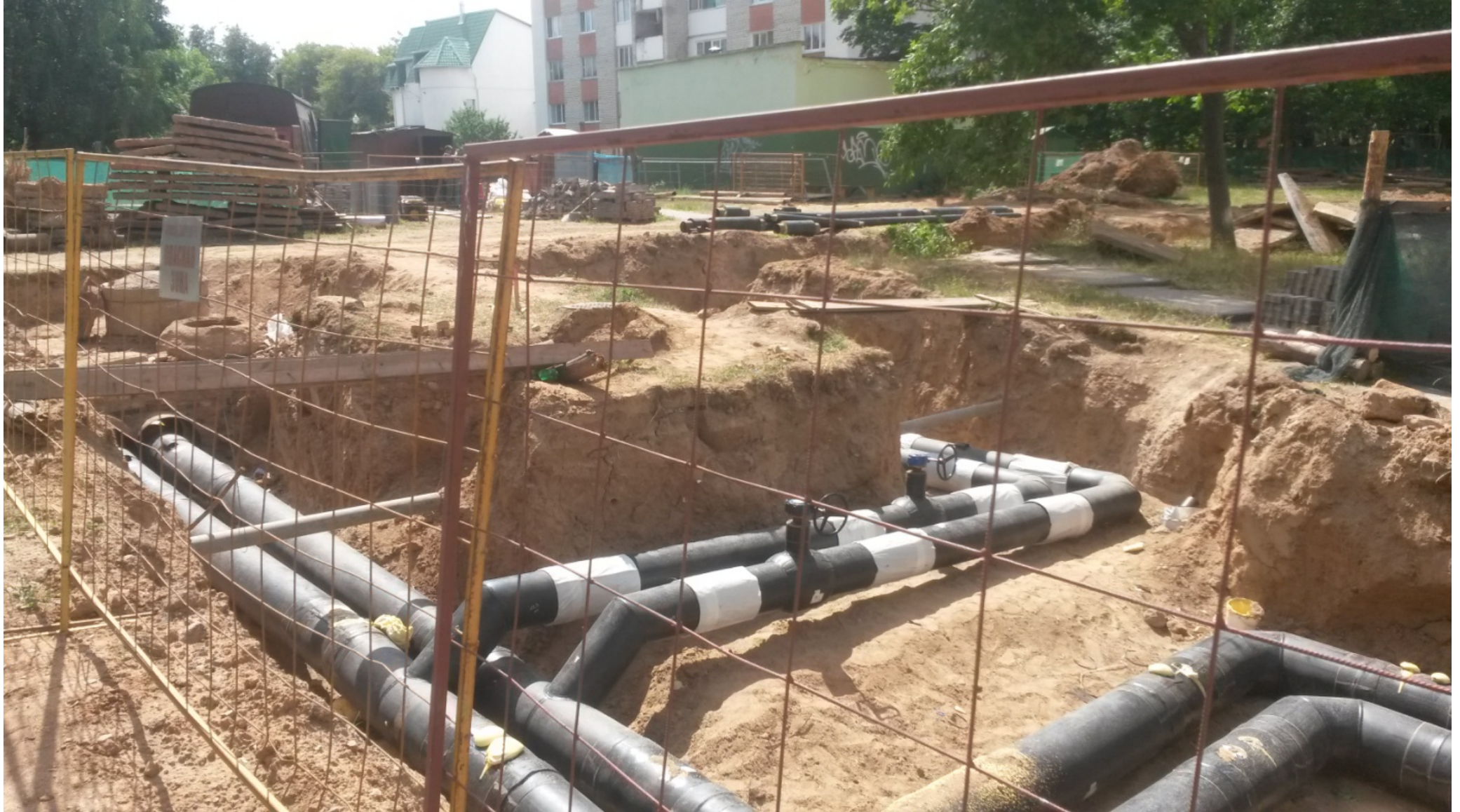
Переходные мостики устроены неверно
